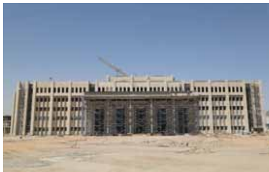
ساختمان در حال ساخت شعبه کربلای دانشگاه علوم پزشکی تهران با همکاری عتبه حسینی (ع)
